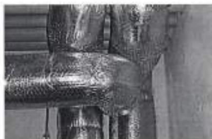
Matelas anti-feu avec revêtement alu résistant aux températures élevées, p. ex. pour les canaux de fumée, les cheminées en acier, les conduits de vapeur à haute pression, la protection phonique et incendie de conduits d'aération des classes de résistance au feu F 30 – F 90.
